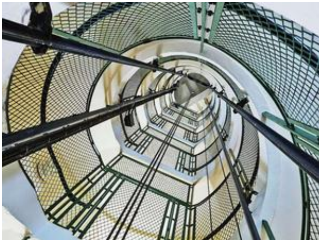
Luft nach oben. Zum altersgerechten Wohnhaus gehört ein Fahrstuhl dazu. Allein in Berlin müsste man laut einer Studie in 10 600 Gebäuden nachrüsten. - FOTO: IMAGO
